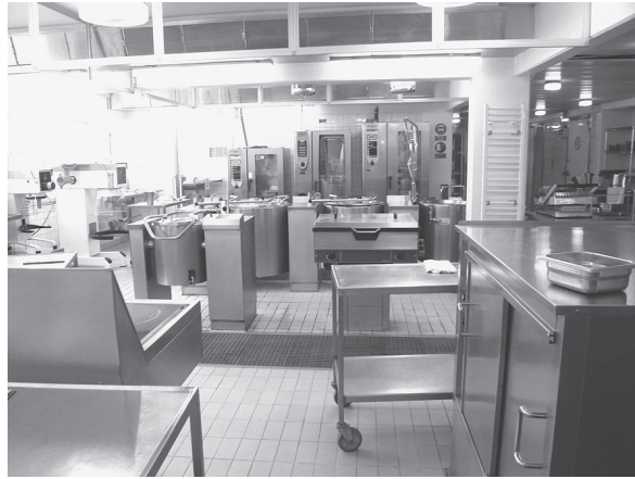
写真6 高齢者施設の厨房
